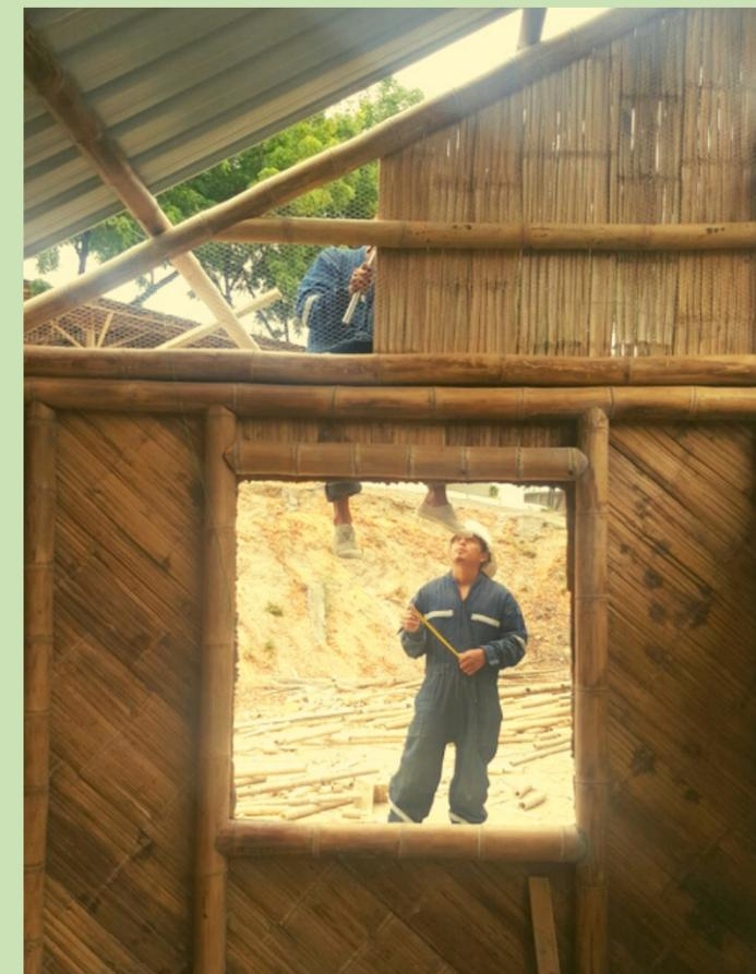
Como sobrecubierta se puede poner teja, planchas de plástico, chapas y paneles de acero, fibra, cemento, membranas o, como en casas tradicionales, hojas de cade o paja toquilla.
