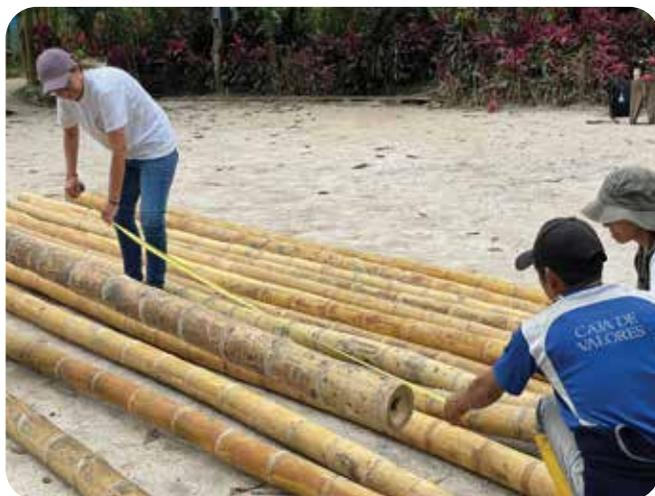
**Ensamblado o prefabricado:** en caso de que se opte por ensamblar los elementos in situ, se debe considerar contar con un espacio adecuado para el trazado de un molde a partir del cual se arman los diferentes elementos como por ejemplo, paneles o cerchas. Será necesario tomar en cuenta que al emplear caballetes se facilita el armado y que también se requerirá emplear algunas herramientas eléctricas.
