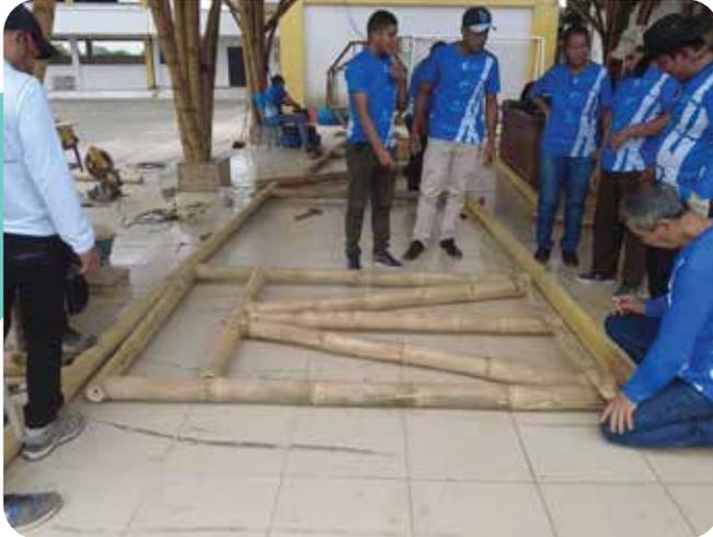
**Montaje:** una vez que los elementos estructurales de hormigón hayan sido realizados conforme las especificaciones del proyecto, se podrá proceder con el montaje de los elementos de bambú. Para esto se deberá prever la utilización de andamios, sogas e incluso, en algunos casos, poleas. Es importante además considerar la necesidad de apuntalar la estructura hasta que se hayan completado los anclajes respectivos.
