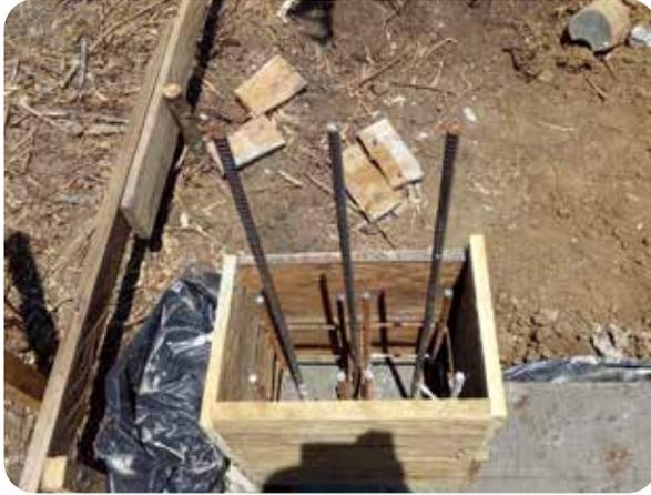
**Armado de hierros:** conforme lo indicado en los planos estructurales, y de manera específica en la planilla de hierros, se deberá realizar el armado de los refuerzos metálicos, estos consisten en varillas de diferentes diámetros, formas y tamaños que son parte de los elementos de hormigón armado como vigas y columnas.
