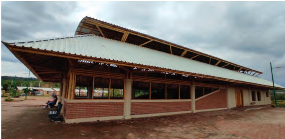
Figura 4. Infraestructura comunitaria que incluye protección del material por diseño, Nobol, Ecuador
