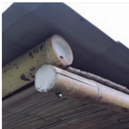
Figura 34. Rajaduras continuas de culmos Fuente: INBAR, 2021
