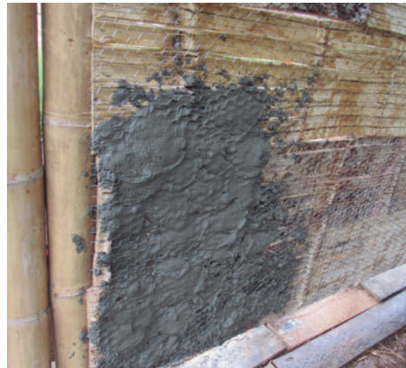
Figura 6. Bahareque encementado, Ecuador Fuente: INBAR, 2019
