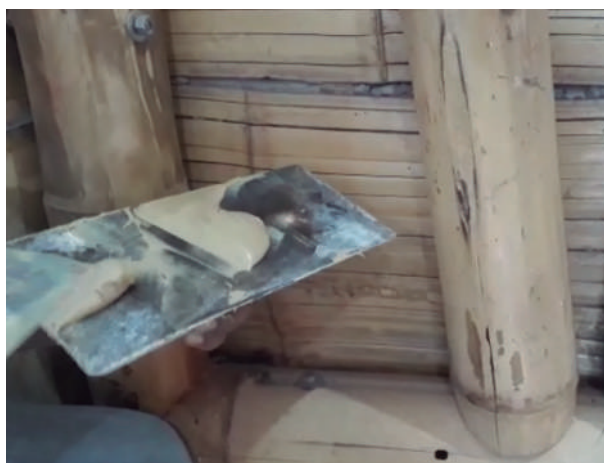
Figura 19. Masillado de fisuras menores que no comprometen más de un canuto
