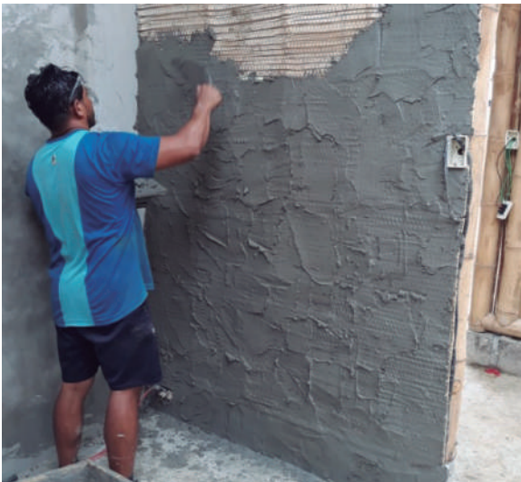
Figura 6. Bahareque encementado, Ecuador Fuente: INBAR, 2019
