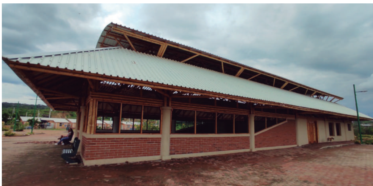
Figura 16. Diseño que incluye protección del material, Nobol, Ecuador
