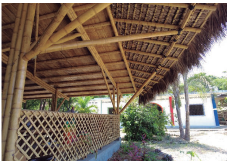
Figura 15. Extensos aleros para protección de bambú, Ecuador
