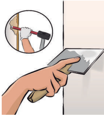
Figura 29. Corrección de fisuras en paredes de bahareque
