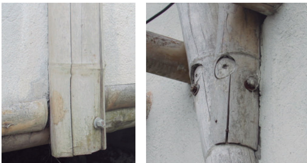
Figura 21. Estructura que presenta rajadura de los culmos por uniones y cortes mal ejecutados Fuente: INBAR, 2021
