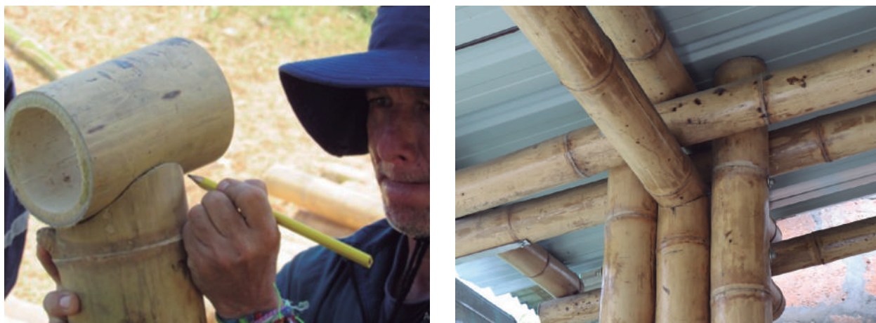
Figura 18. Cortes y uniones adecuadas
