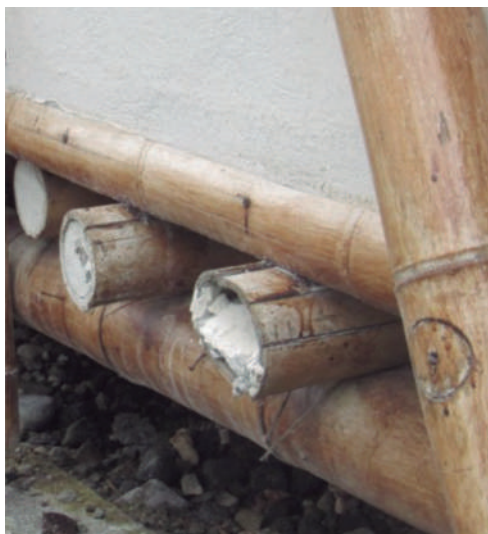
Figura 22. Estructura que presenta rajadura de los culmos por aplastamiento Fuente: INBAR, 2021
