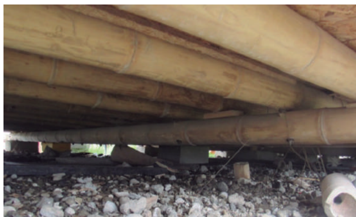
Figura 37. Culmos pandeados Fuente: INBAR, 2021
